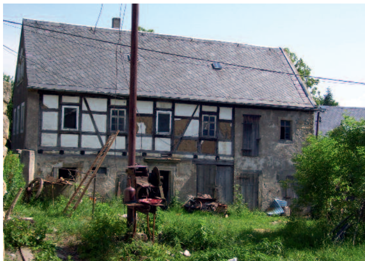
Hofansicht des Auszugshauses zum Zeitpunkt des Kaufes. Das Fachwerk war auf dieser Seite nahezu zerstört und sanierungsbedürftig, Fenster und Dachdeckung mussten erneuert werden
