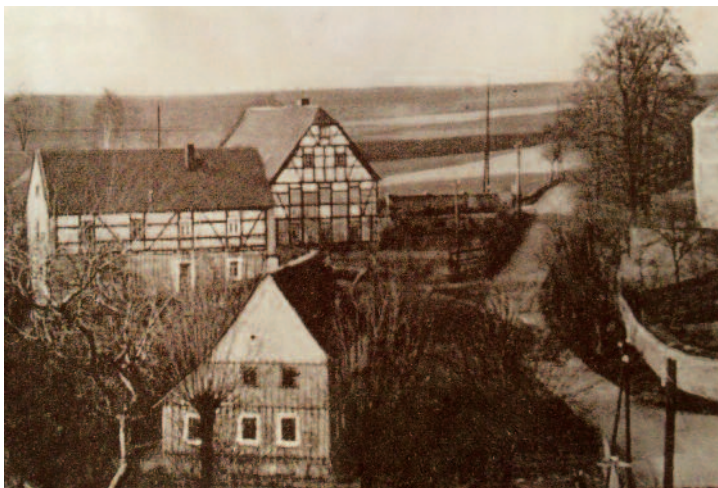
Der Löbnerhof auf einer alten Postkarte. Das Wohnhaus rechts und in der Traufansicht das Auszugshaus. Das kleine Häusleranwesen im Vordergrund ist bereits dem Abriss zum Opfer gefallen
